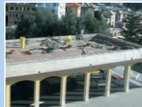
L'inizio dei lavori.
